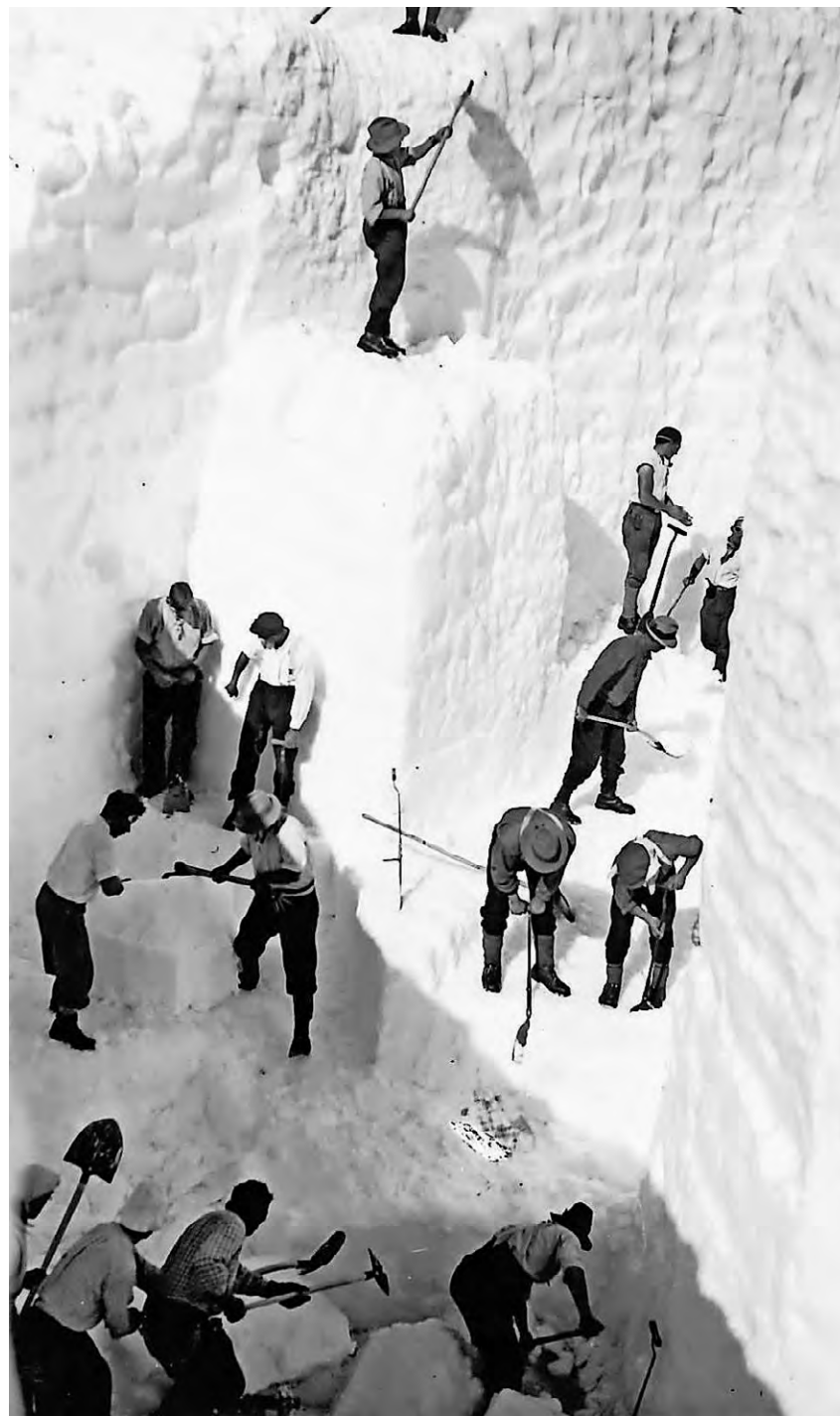
Schneebrucharbeiten zur Öffnung der Gotthardpassstrasse im Frühling 1936. Der Schnee liegt übermannshoch und wird in Stufen abgetragen. Trotzdem spricht der Rechenschaftsbericht über die Staatsverwaltung des Kantons Uri «von mildem Winterwetter und kleineren Schneemengen auf den Alpenpässen».
