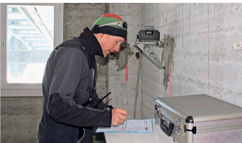
Urs Roos misst an Fixpunkten mit einem Clinometer die Neigung der Wände der Bergstation, hier im 2. Obergeschoss.
